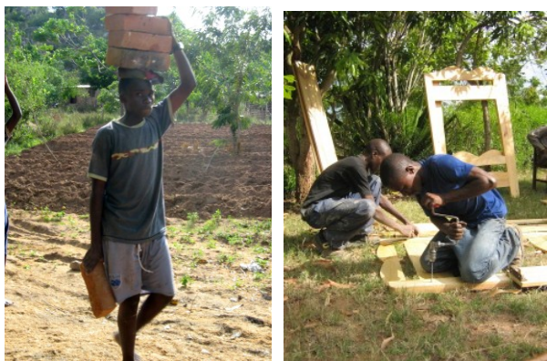
Helpen bij de bouwactiviteiten
