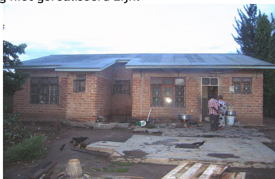
Het Back Home House tijdens de verbouwing
